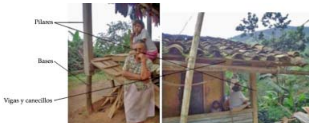
Fig. 2: Casa típica de la zona montana bajo y la descripción de las principales partes que la componen.
